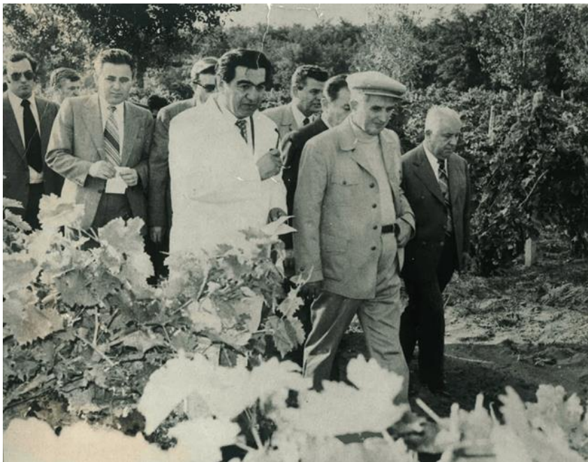
Vizita președintelui Nicolae Ceaușescu la Stațiunea Dăbuleni
